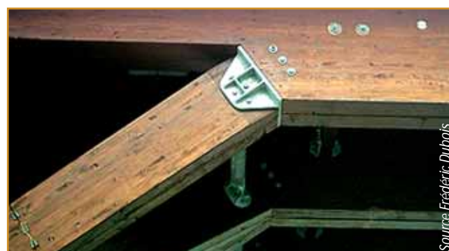
Source Frédéric Dubois La qualité des systèmes constructifs, en complément de celle du matériau, contribue à la longévité des ouvrages d'art.
