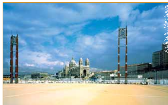
Architecte : Marc Speeg Les qualités de durabilité et de résistance du Douglas sont source d'innovation, à l'image de ces mâts en lamellé-collé construits en bordure de mer, à Marseille.
